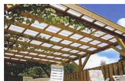
4. На территории спортивной площадки размещается крытая беседка с двумя деревянными столиками и лавками вокруг. Конструкция выполнена по каркасу с обшивкой деревом и крышей из поликарбоната
