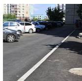
1. На проезжей части применена асфальтовая крошка
