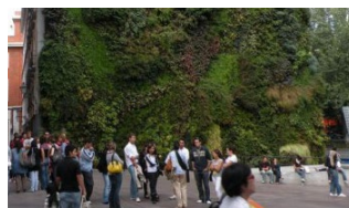
5. Для отделки фасадов ЦТП И ЦТП2 применяется вертикальное озеленение
