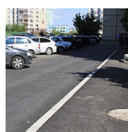
3. На проезжей части применена асфальтовая крошка
