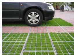
1. На парковочных площадках укладывается газонная решётка
