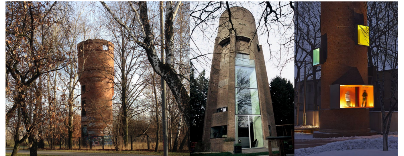
ВИДОВАЯ ПЛОЩАДКА ВОДОНАПОРНОЙ БАШНИ
